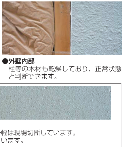
●断熱材 断熱材のロックウールも乾燥しています。 ●剥がしたパネル (表面) 基礎に接する一段目で、納まり上パネル幅は現場切断しています。裏面も含め、良好なパネル状態を保っています。
