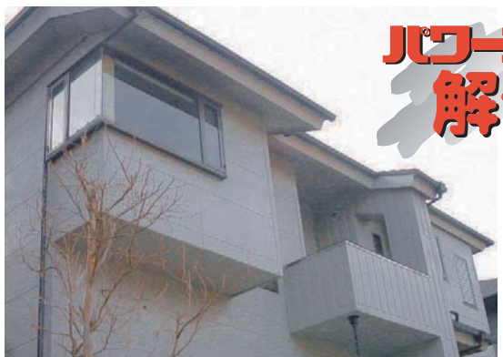
●築17年目のパワーボード使用住宅外観。全てのパネルにクラック、反り等の変化は見られませんでした。メンテナンスは3年前 (築14年目) に外装塗装を実施。
